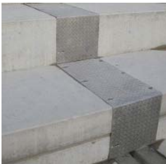
Рисунок 14: Защитная конструкция стальной скользящей наклейки
