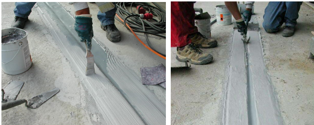
Рисунок 10: нанесение завершающего слоя
