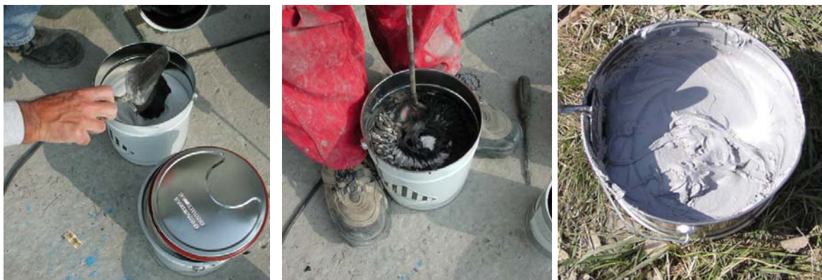
Рисунок 7: перемешивание системного клея
