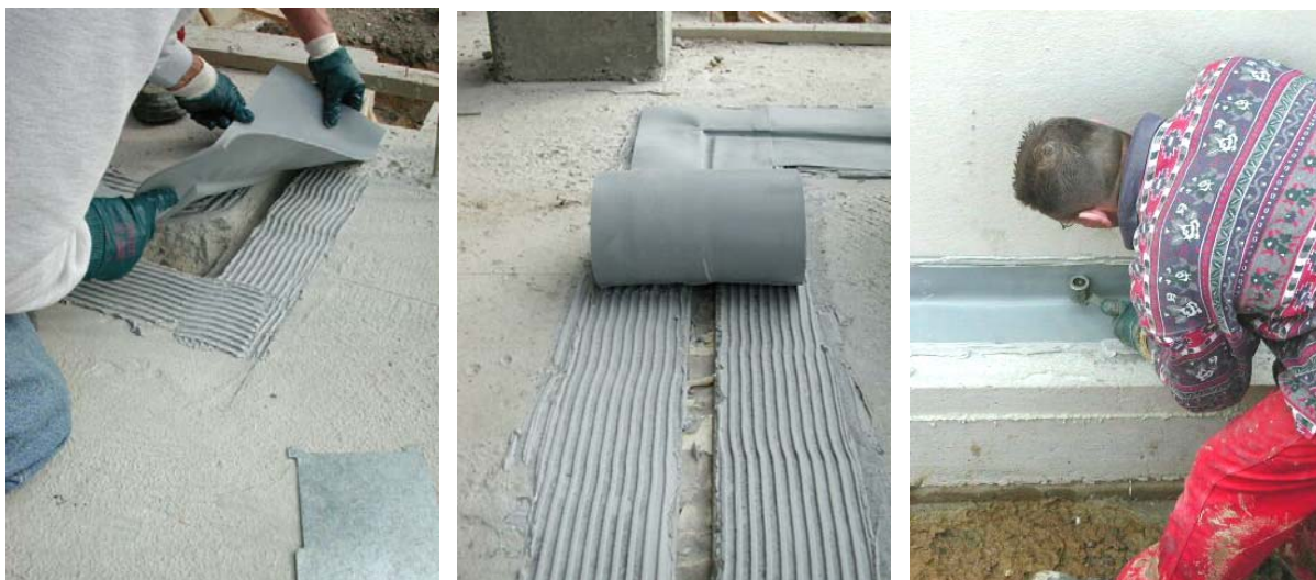
Рисунок 9: нанесение герметизирующего элемента
