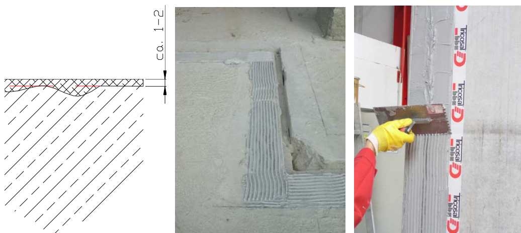
Рисунок 8: нанесение основного слоя клея
