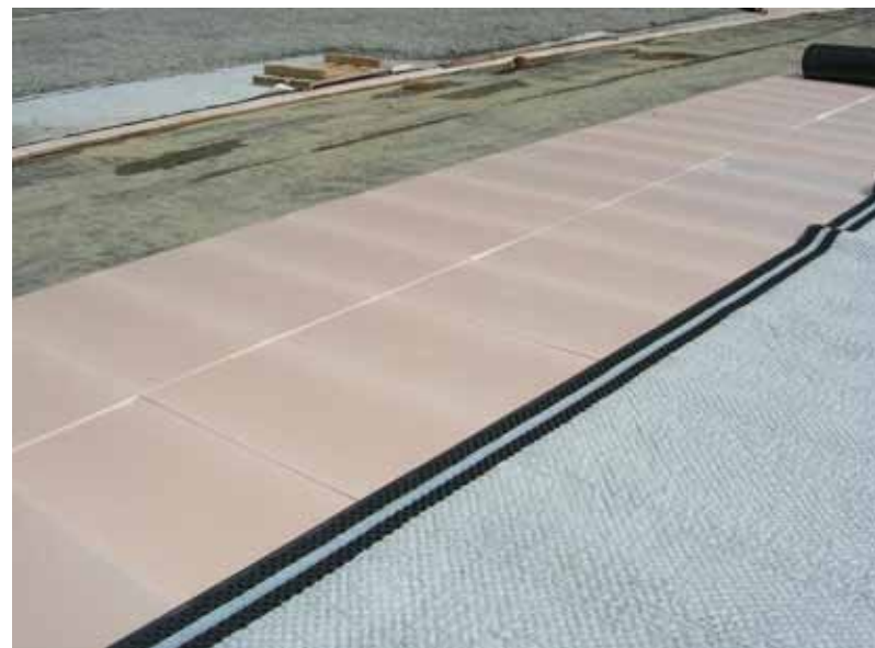
Укладка основных слоев (гидро - теплоизоляция и мембрана Тefonд «Drain Plus»)
