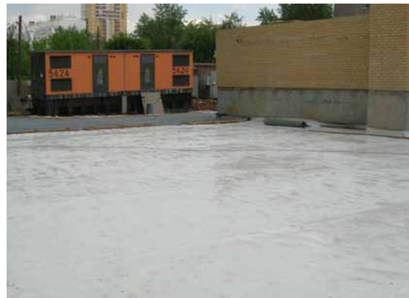
Укладка основных слоев (мембрана «Barrier TPO», мембрана Тefonд «HP»)
