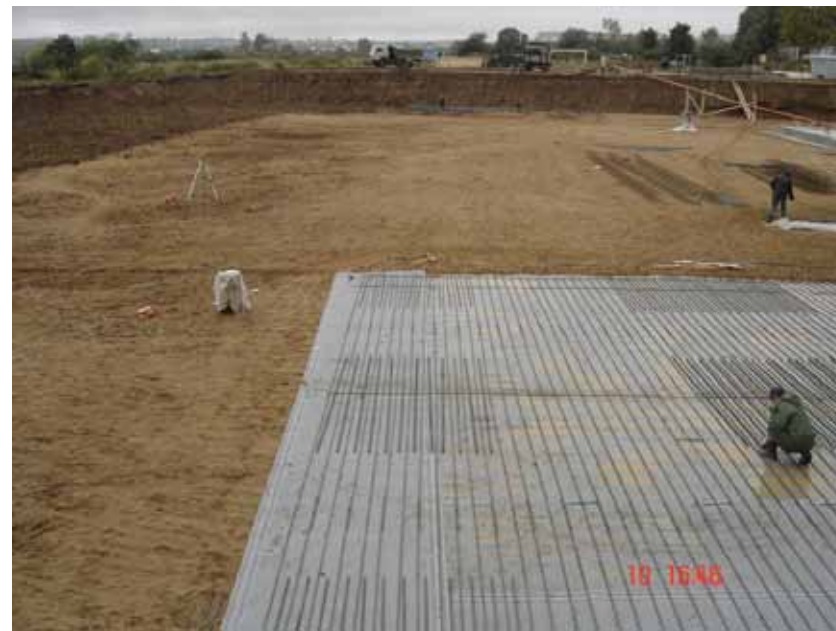
Укладка мембраны на основание
