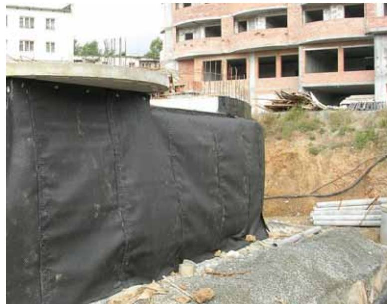
Монтаж основных слоев (слой гидроизоляции и мембрана Тефонд «Drain Plus»)
