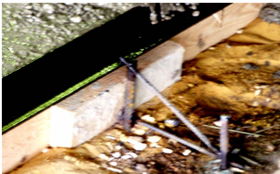
Рис. 11. Схема приваривания уголков опалубки к анкерам
