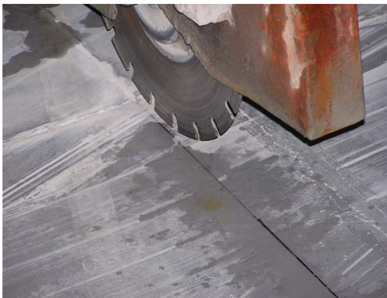
Рис. 12. Схема нарезки швов
